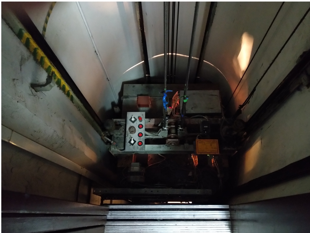
Wnętrze szybu dźwigowego
