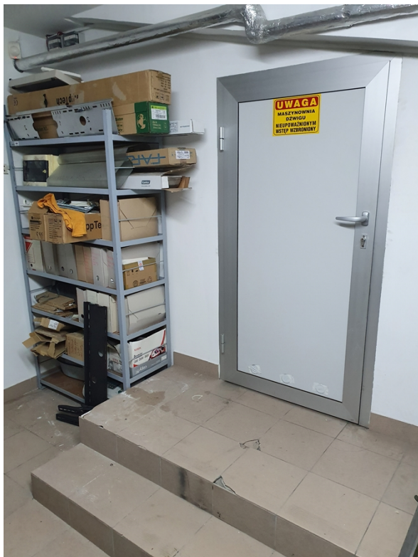
Drzwi do maszynowni
